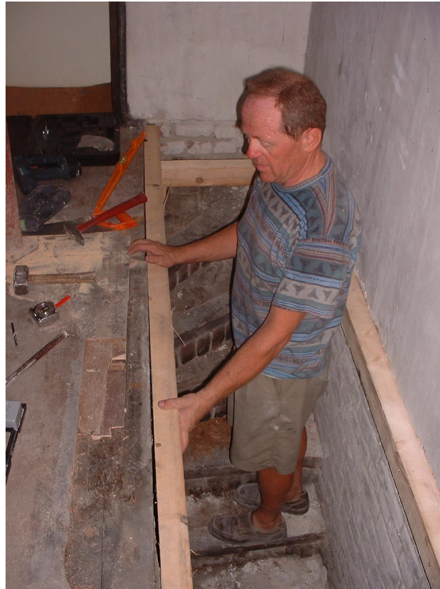
Sous l'emplacement d'un escalier de service qui a été démonté, Alain menuisier va réaliser une trappe dans la trémie d'un accès à une petite cave.
