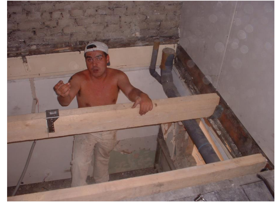
7août 2003 pose du plancher de la cuisine du R+3 il y avait là une verrière qui éclairait une salle de bains. Hervé DELVAL de Métropole Constructions
