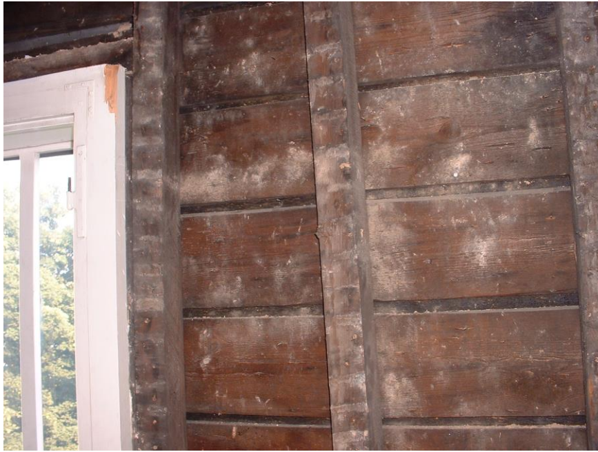
Au R+3 démolition des cloisons, mise à nu des brisis Pose d'un plancher avec sabots
