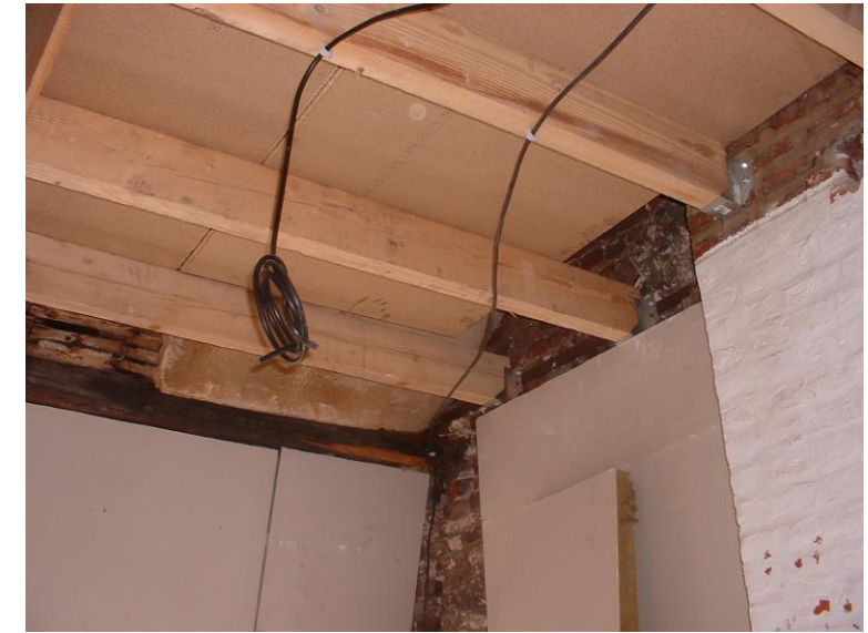
Pose de cloisons isophoniques, composées de 2 BA13 de chaque coté et laine de roche au milieu Contre les murs, isolation et placoplâtre 8+1 Le plancher séparant du R+4 sera isolé entre poutres, au dessus des plafonds.
