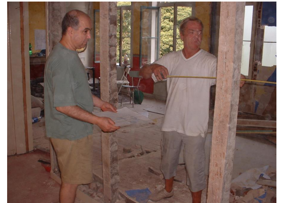
Le gros œuvre continue les démolitions au R+2 12 août 2003.
