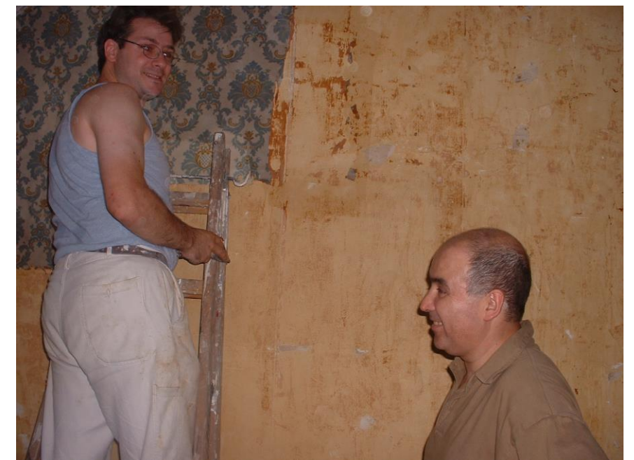
11 août 2003 L'entreprise Martin détapisse la cage d'escalier sous l'approbation de François BENNASSAR Architecte.
