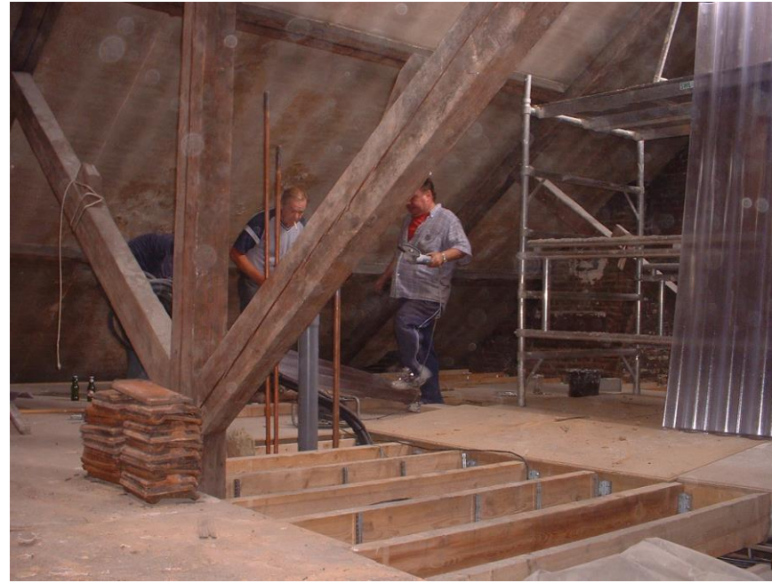
Le 22 août travaux en toiture, remplacement des partires lumineuses par des panneaux en poly carbonate.
