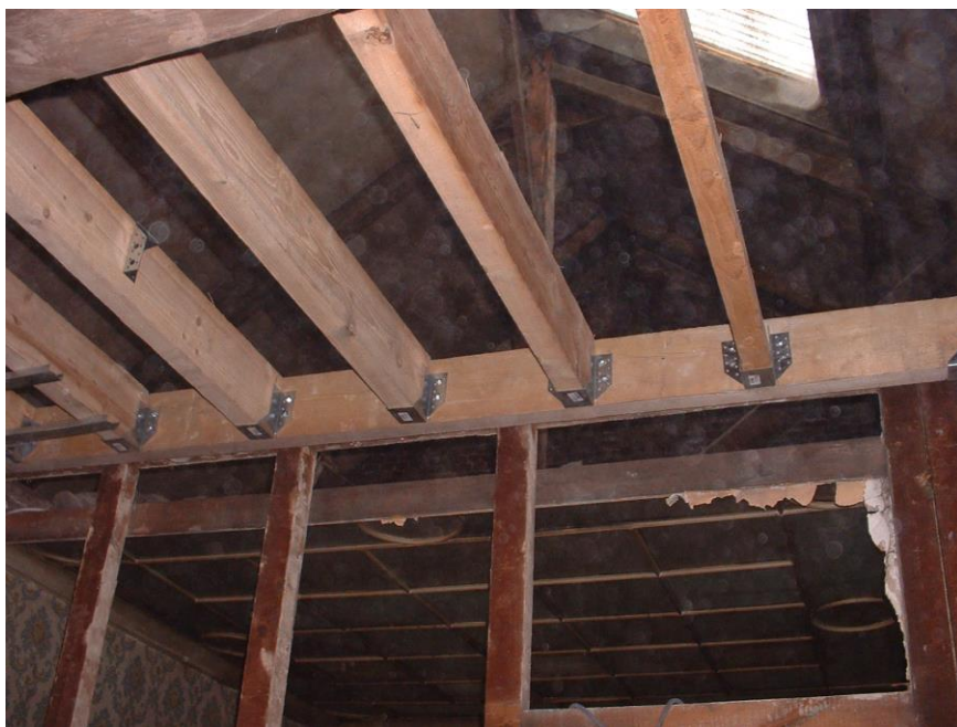
Au R+3 démolition des cloisons, mise à nu des brisis Pose d'un plancher avec sabots
