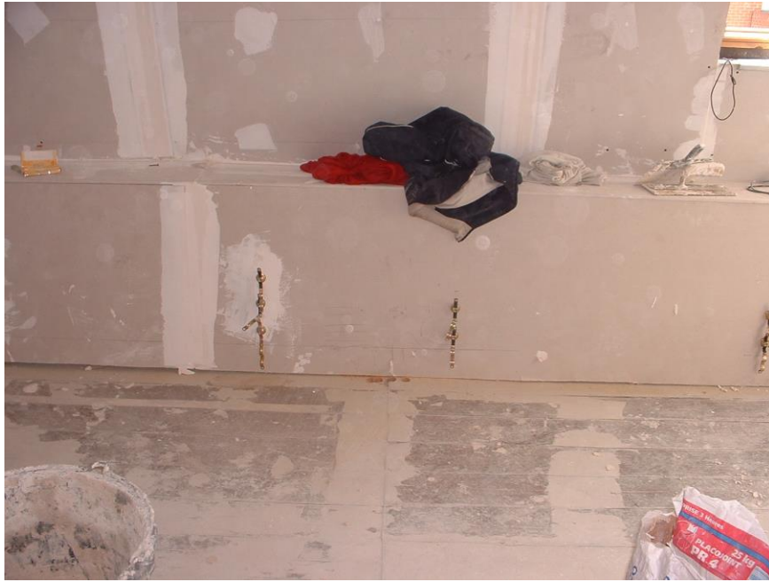
Au R+3 on pose des calicots et des enduits, La gaine technique se structure électricité et chute en PVC.
