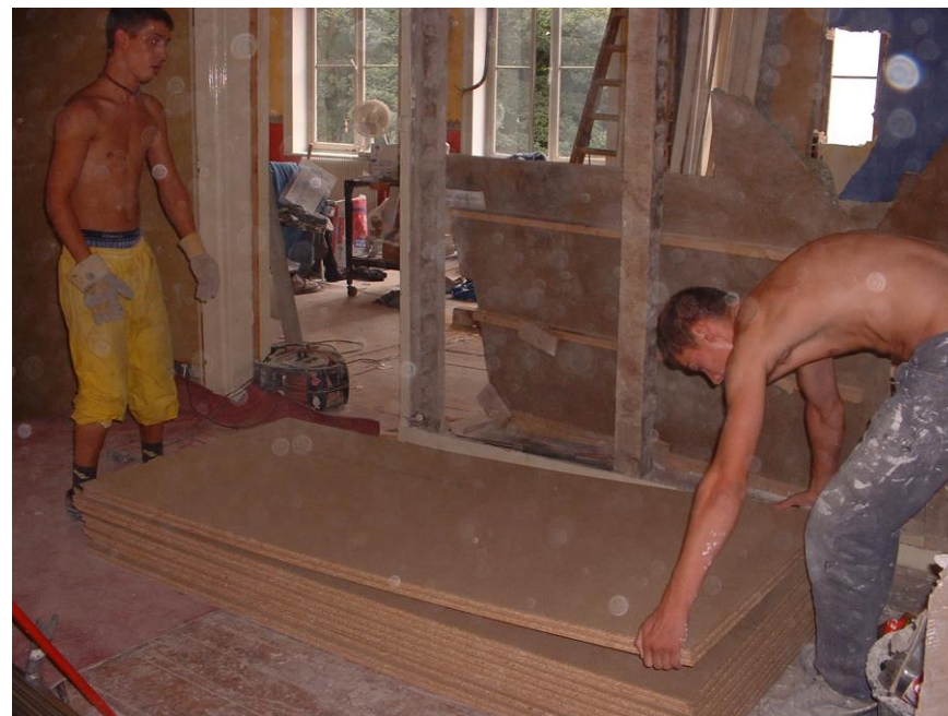
Le 21 août, au R+2 Steve et Manu amènent les panneaux BA13 de placoplâtre. Le 26 août l'entreprise EBF terminent les arrivées d'eau au R+3, dans la cuisine commune et dans les chambres.
