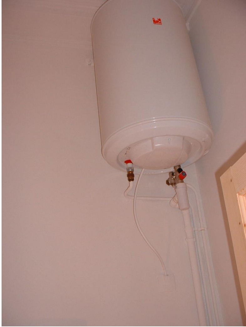
Salle d'eau accessible par la chambre.
