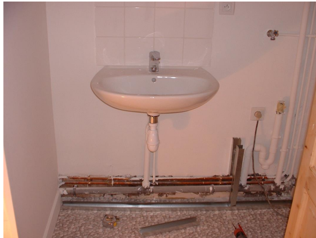
Lavabo type + emplacement pour Lave- Linge.
