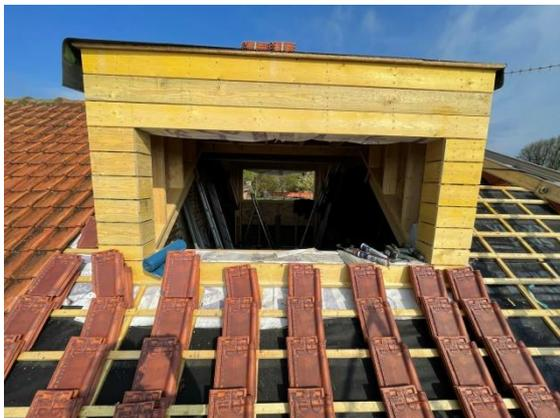
Jendredi 29.04.21 pose des tuiles neuves après la sous toiture et le lattage.
