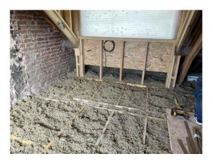
Mardi 25.05.21 Le plancher est rempli de laine de roche, Ludovic Robinet de l'atelier Carlier va poser du phaltex sur la tranche des poutres du plancher pour la désolidarisation et isolation phonique.
