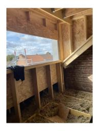
25.05.21. Les ouvertures ont été occultées par des panneaux, et vont bientôt être fermées par les châssis métalliques.
