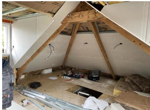
Les panneaux de Placoplatre sont posés, grande longueur, 3.00m, au bas du versant Nord Est.
