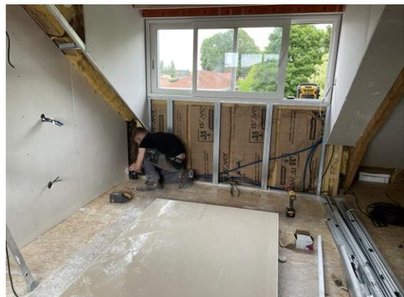
Arrivées électriques pour le radiateur et les Volets roulants., de chaque côté du lit aussi. 11.06.21
