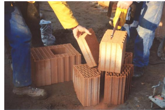
sciage de briques, pour ajuster la longueur du mur.
