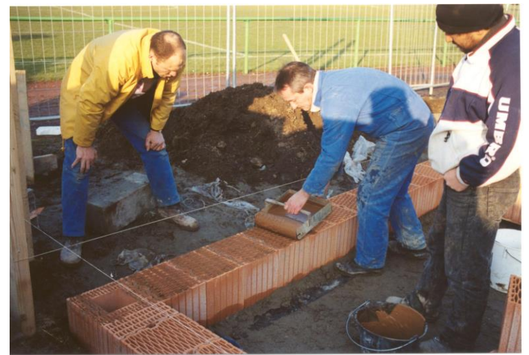
sciage de briques, pour ajuster la longueur du mur.
