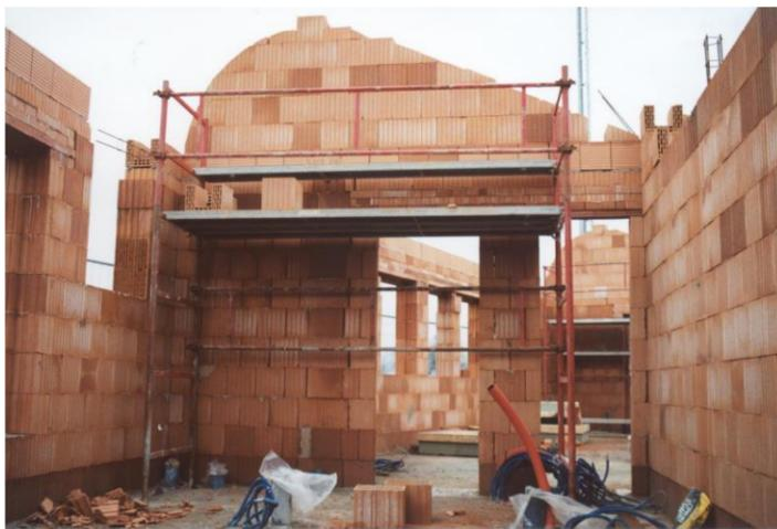
**Des achelets en béton, pour les futurs sabots des poutres NAILWEB**
