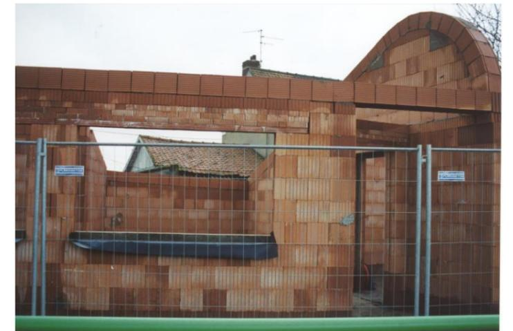
**Les 4 premiers blocs de l'arc sont inversés pour former le coffrage du béton.**
