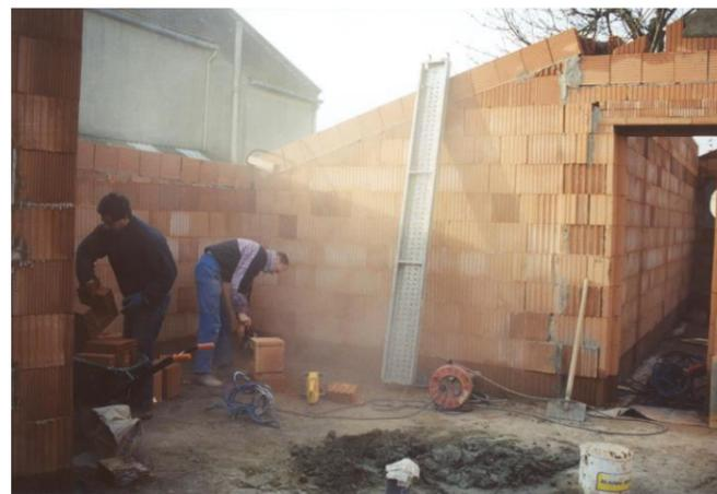
**Des briques BIOMUR en U sont sciées pour former le chaînage en arc.**
