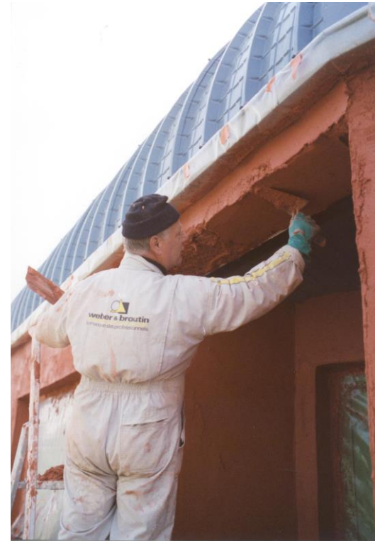
Un endroit difficile, avant la pose du plafond métallique extérieur.
