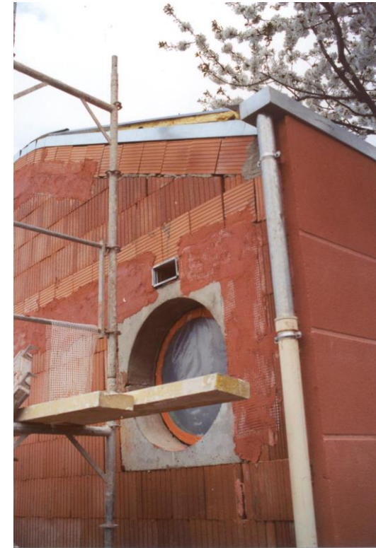
Pose de grillage sous l'enduit aux endroits singuliers.
