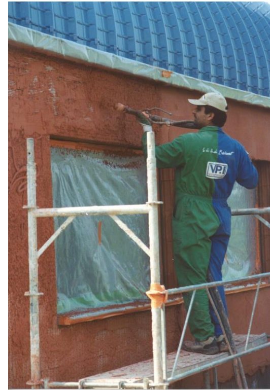
L'enduit en pâte est projeté avec de l'air comprimé.
