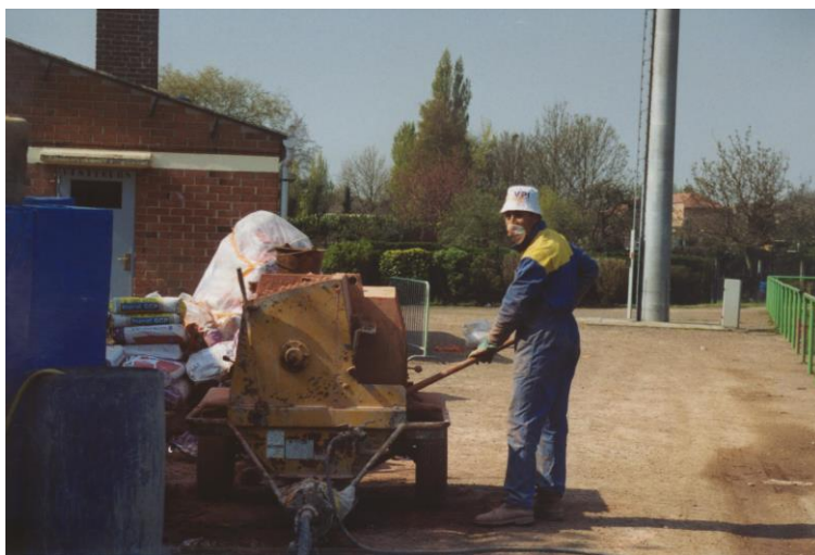
Un ouvrier procède au mélange de l'enduit avec de l'eau.
