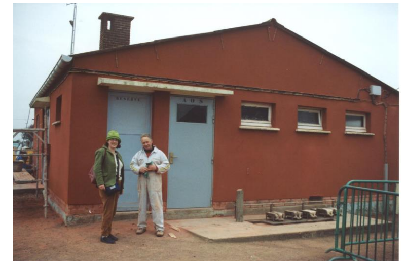
Enduit sur le vestiaire des joueurs existant.
