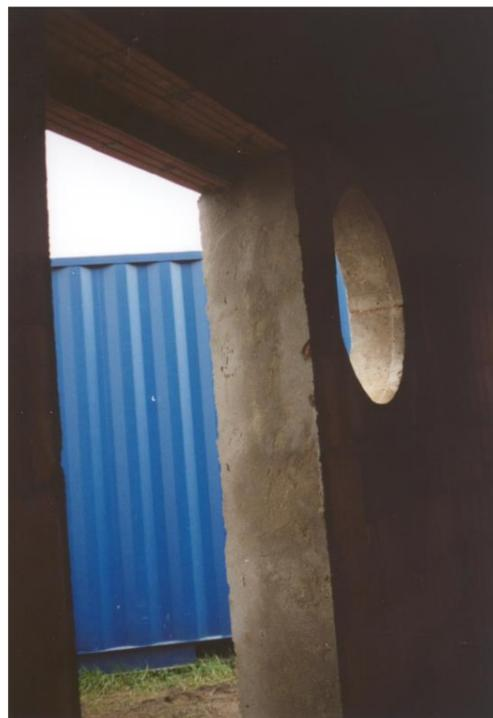
Les feuillures BIOMUR sciées, car écart - porte trop étroit, les tableaux ont été cimentés. La pose des menuiseries sera faite avec un recul de 12 cm.
