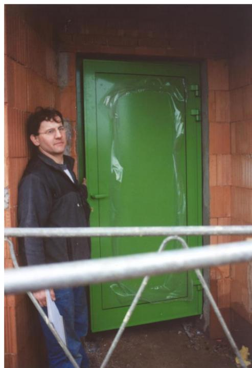
Porte en aluminium double paroi, âme isolante, RAL 6018.
