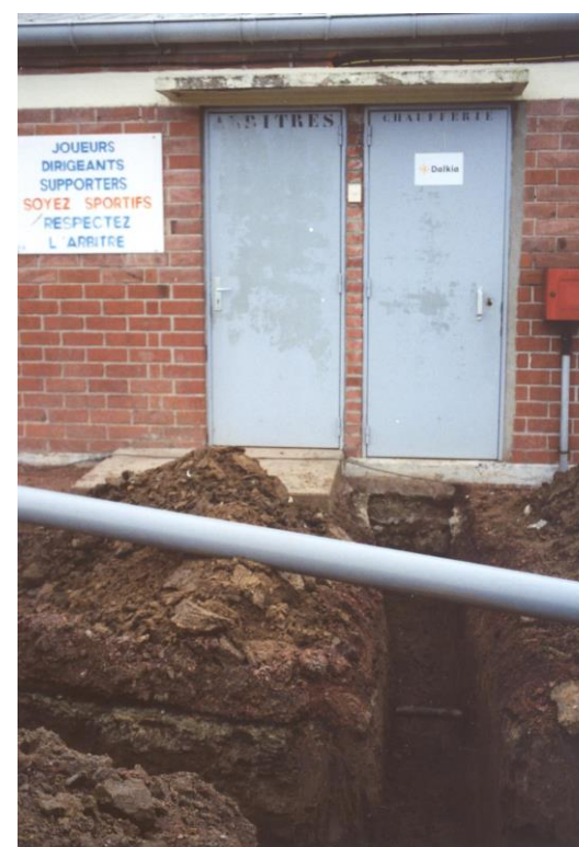
La fosse septique du vestiaire des joueurs sera reliée au réseau unitaire. On voit ici la conduite d'arrivée d'eau.
