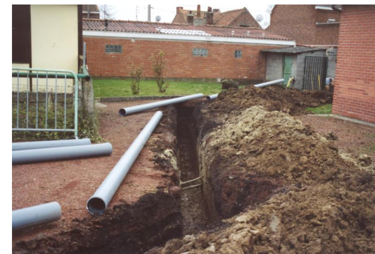
Passage de la conduite de gaz.
