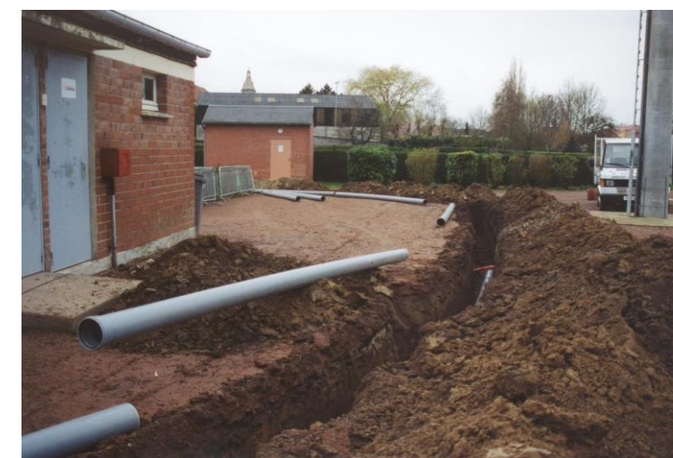
on aperçoit un fourreau électrique.
