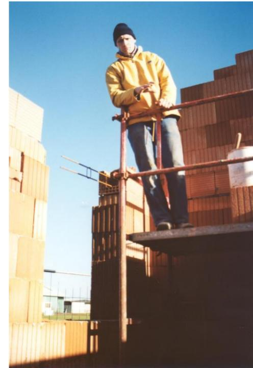
**La maçonnerie s'élève, le maçon forme la pente des murs de la réserve.**
