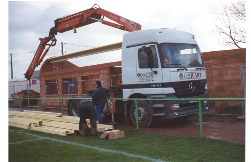
Entreprise COQUART avec Mr DUPAYAGE dessinateur et Mr MEZROUH conducteur de travaux.
