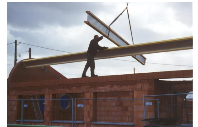
Le grutier manœuvre le camion grue, les deux charpentiers posent les poutres en 4h.
