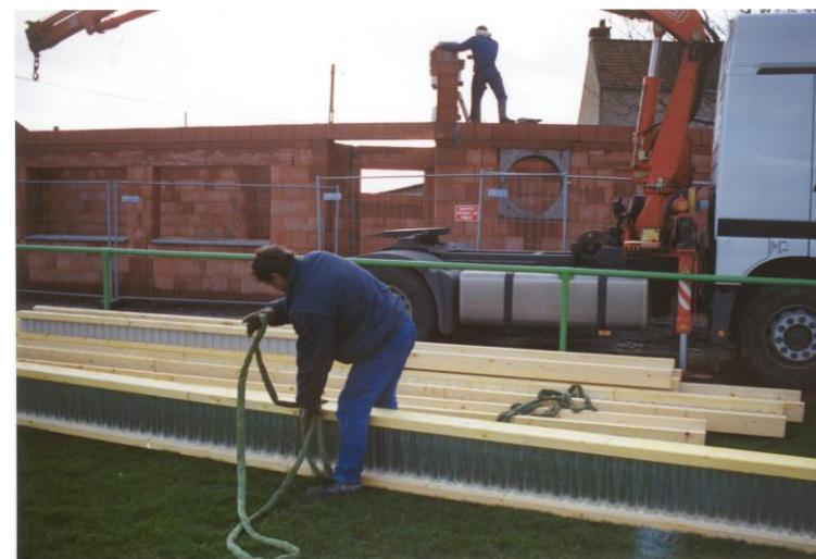
Pose des poutres NAILWEB le mardi 26 février
