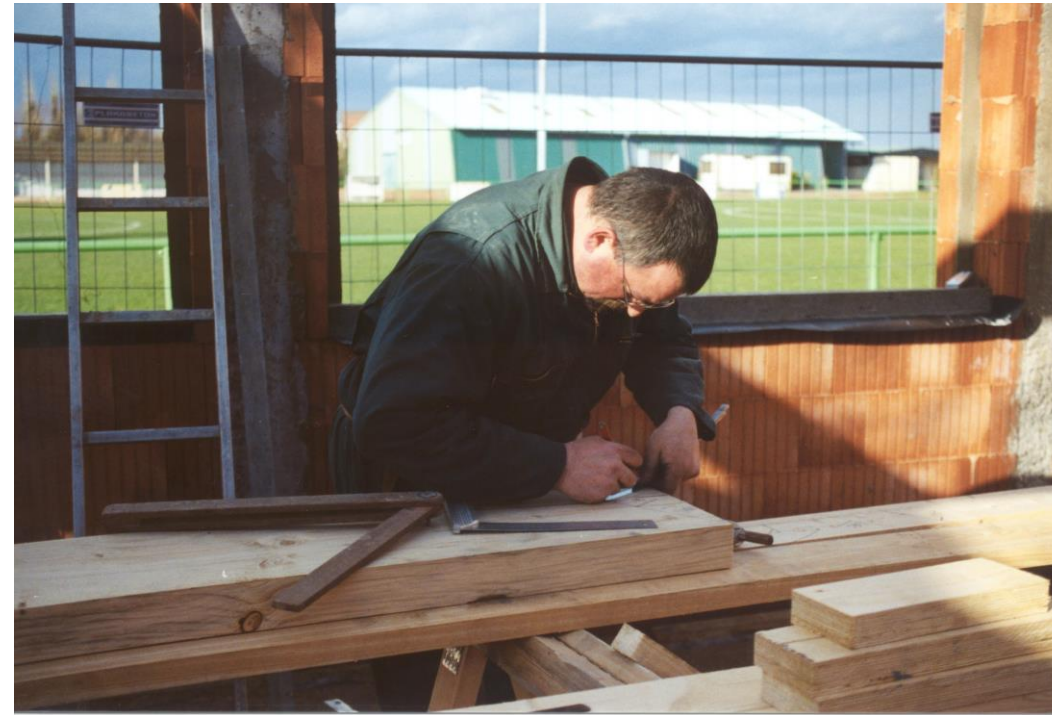
Mr CHIVE charpentier façonne les appuis des entretoisements avec l'équerre à régler.
