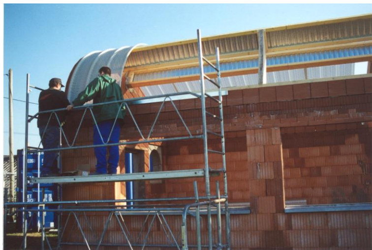
L'entreprise Dujardin revient pour rectifier la hauteur d'un mur.
