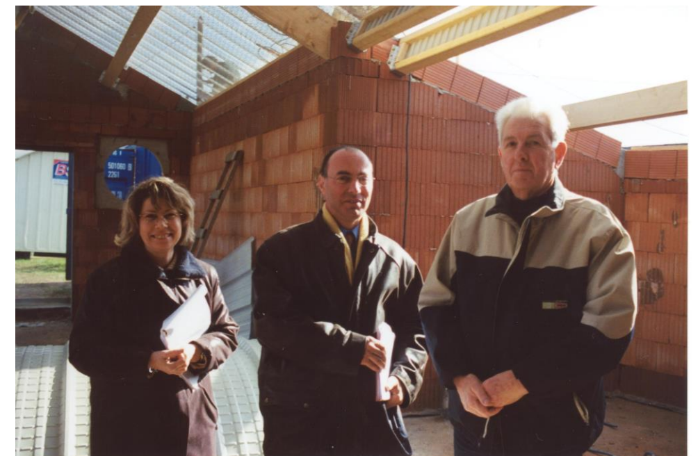
Club-house et vestiaire d'arbitres Stade Bétrancourt
