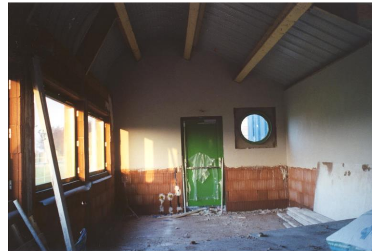
Les pièces s'éclaircissent depuis le 11 avril 2002, lorsque les murs sont enduits. La ventilation primaire des douches est montée.
