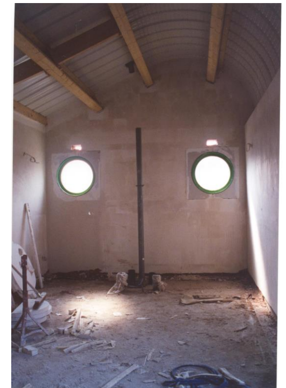
Les pièces s'éclaircissent depuis le 11 avril 2002, lorsque les murs sont enduits. La ventilation primaire des douches est montée.
