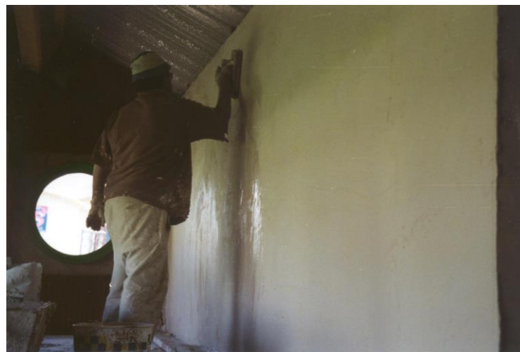
Plusieurs gestes sont nécessaires pour appliquer le plâtre projeté.
