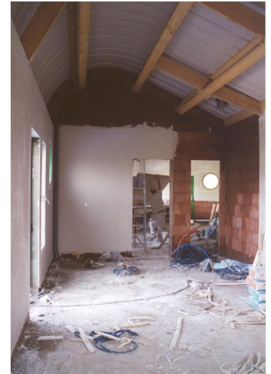
Les pièces s'éclaircissent depuis le 11 avril 2002, lorsque les murs sont enduits. La ventilation primaire des douches est montée.
