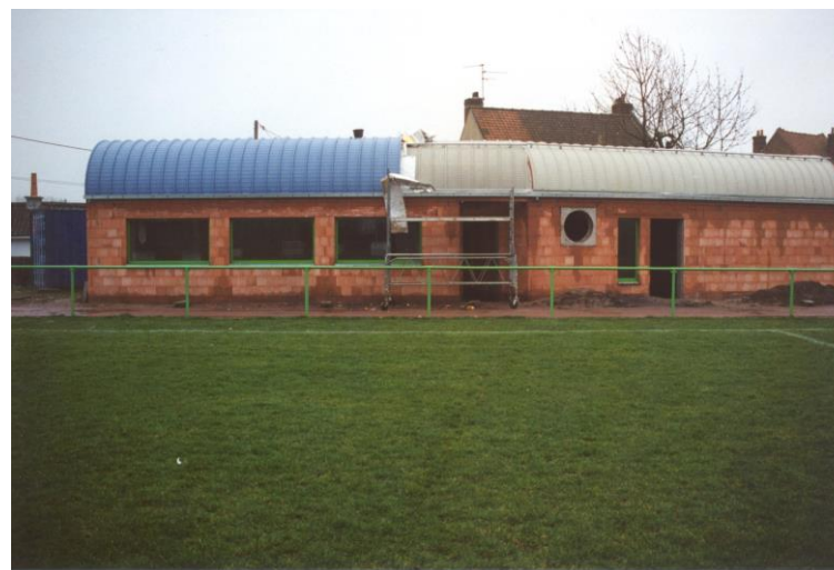
Chantier le 13 mars 2002
