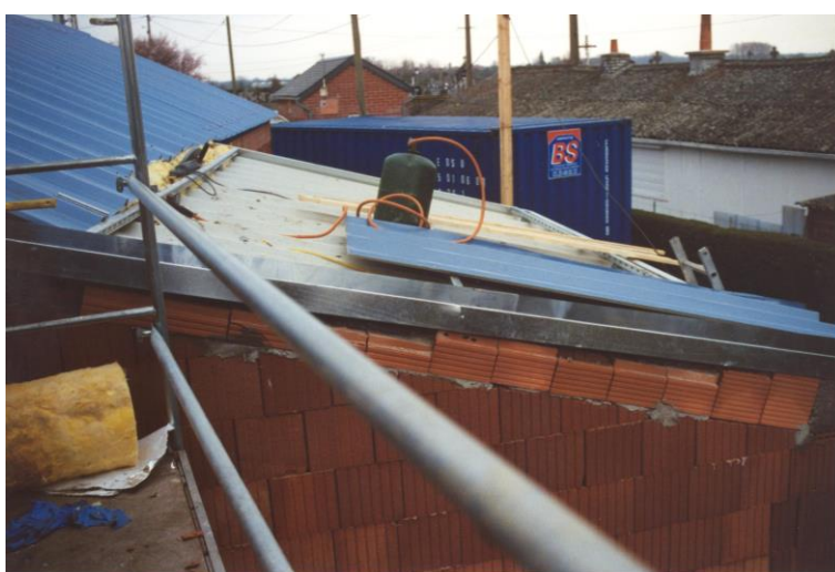
Pose de la seconde peau, bac acier 3.45.1000 TS RAL 5014 15.03.2002
