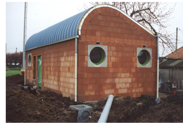
Les rives seront posées ultérieurement, après les enduits.
